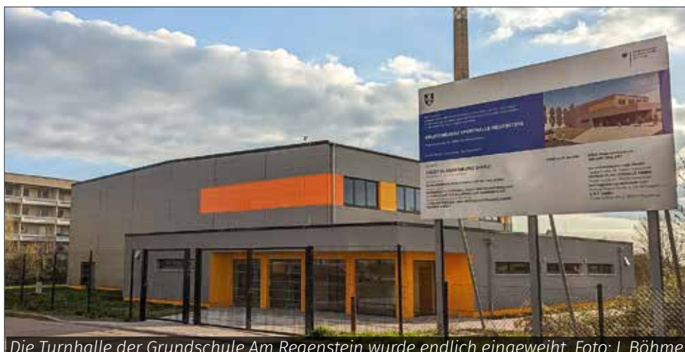
Die Turnhalle der Grundschule Am Regenstein wurde endlich eingeweiht. Foto: J. Böhme
